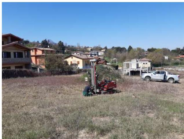
**Prova penetrometrica statica CPT2**
